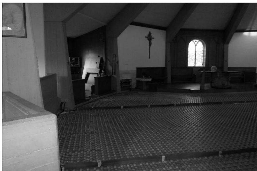
Di conseguenza è stato installato il riscaldamento sopra il pavimento esistente, sistema di riscaldamento che è stato annegato in un getto chiamato “massetto” e dopo il periodo previsto per l’essiccazione è stato posato il nuovo pavimento.
